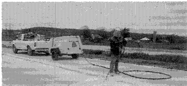
Cleaning joints with high-pressure air Limpieza de juntas con aire a alta presión
